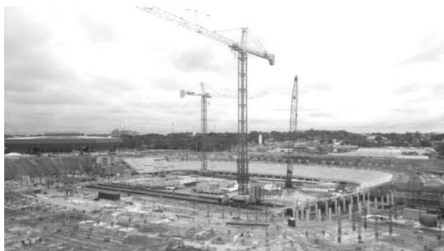
Arena da Amazônia tem estrutura de fundação concluída (Eric Gamboa/Agecom)
